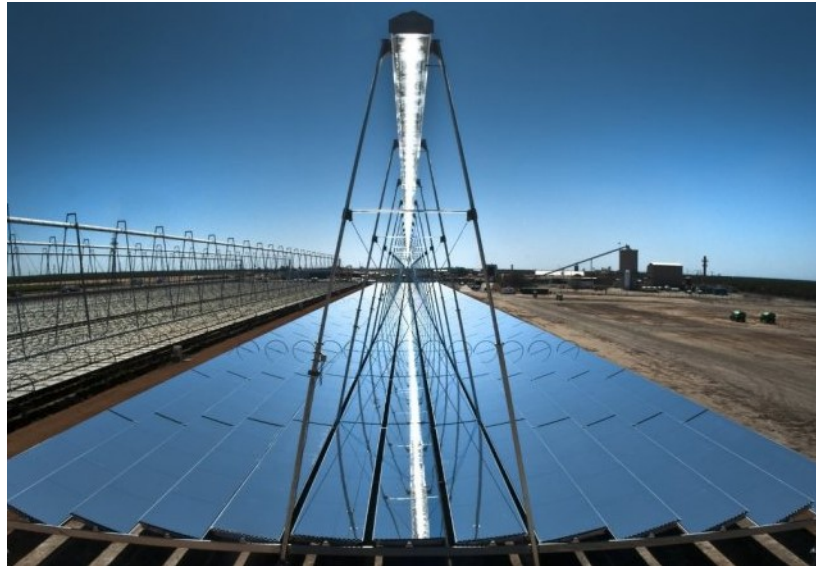
Рисунок 1.2 – Сонячна електростанція концентраторного типу
