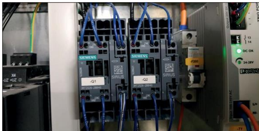
Рисунок 3.5 – Контактори, що живлять відповідні конвеєри
