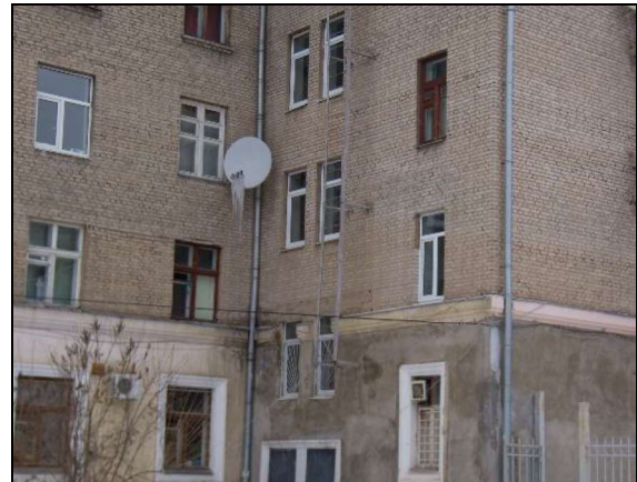
Рис. 5 – Дефект конструкции здания. Стык между фасадами С и D
