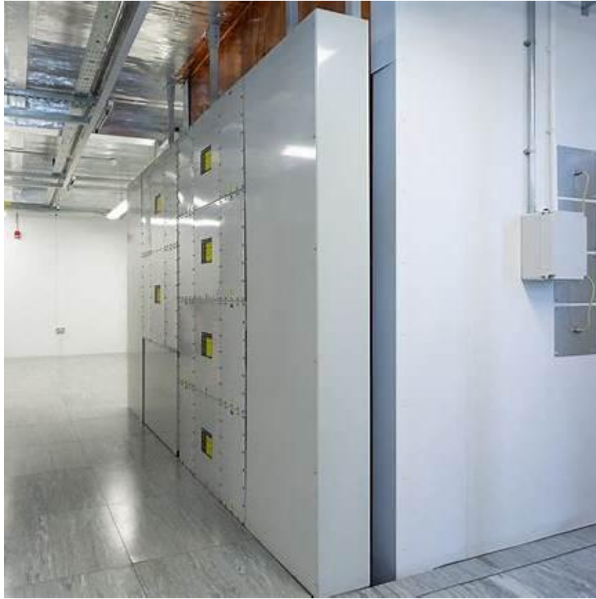
Рисунок 2.1 – Камера/кімната з екранізацією (Faraday / TEMPEST-кімната)
