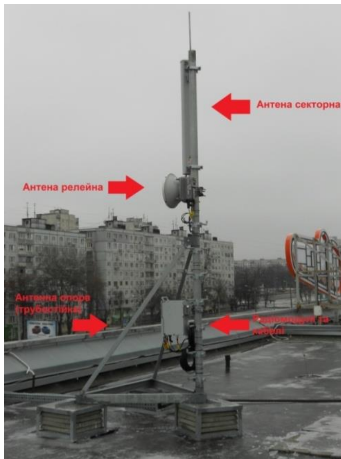
Рисунок 2.3 – Приклад встановлення обладнання на даху будівлі
