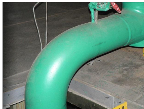
Рис. 8 – Зона кавитационной эрозии (дефект утонения стенки трубы), зарегистрированная в разных ракурсах (а–б).
