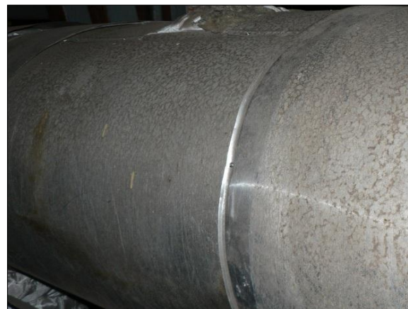
Рис. 2 – Участок паропровода высокого давления с возможным развивающимся дефектом
