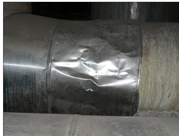
Рис. 1 – Локальные тепловые аномалии, вызванные рельефом поверхности защитного экрана
