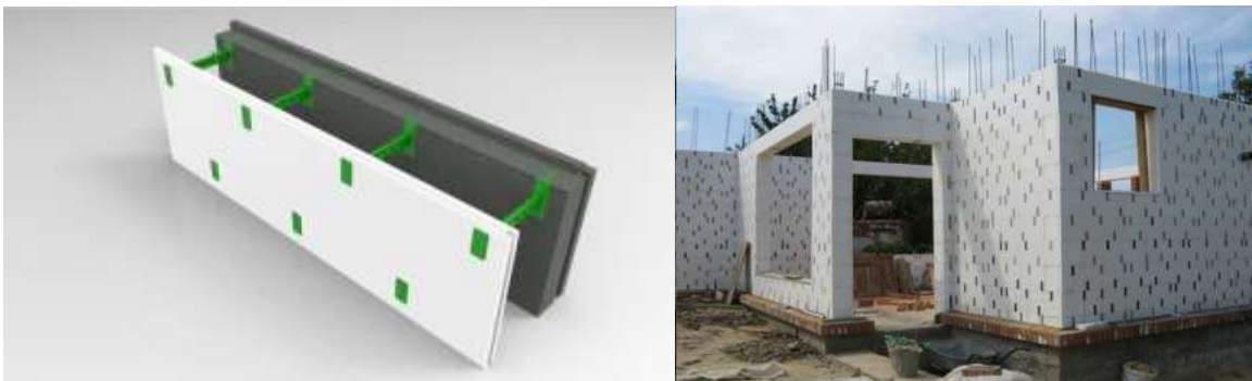
Рисунок 1.6 – а) 3D модель незнімної опалубки б) Приклад створення каркаса будинку з деталей незнімної опалубки
