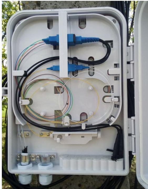
Рисунок 2.12 – Змонтований бон бокс з працюючими абонентами
