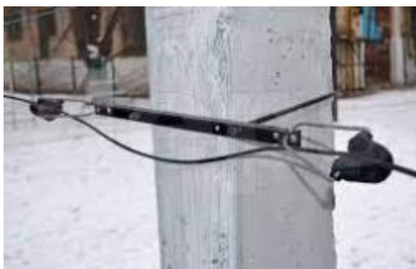
Рисунок 2.11 – Приклад монтажу кабелю на стовпі
