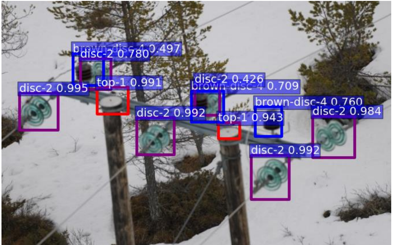
Рисунок 1.1 – Виявлення дронами пошкоджень на ЛЕП
