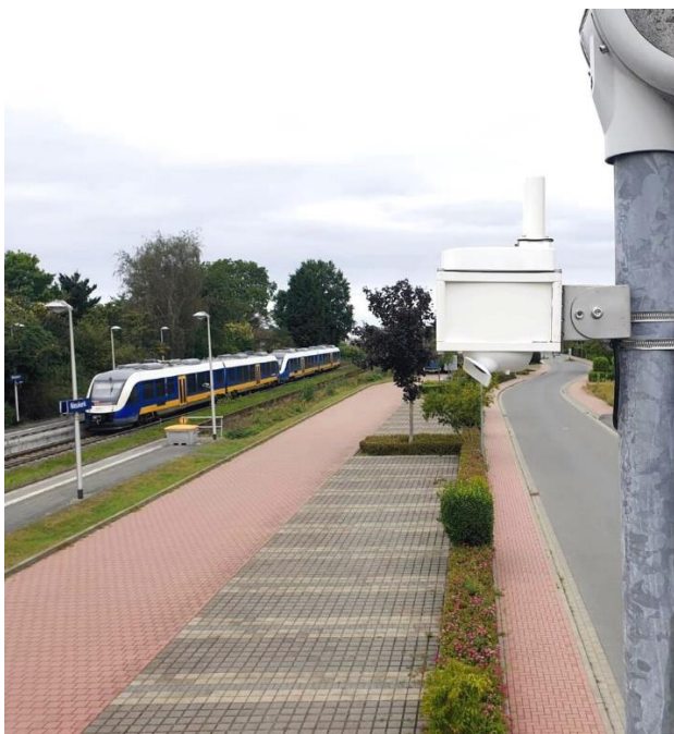
Рисунок 1.6 – Датчик Clevercity Sensor на опорі вуличного освітлення
