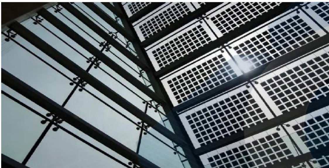
Рисунок 4.5 - Варіант фасадного використання двосторонніх сонячних панелей
