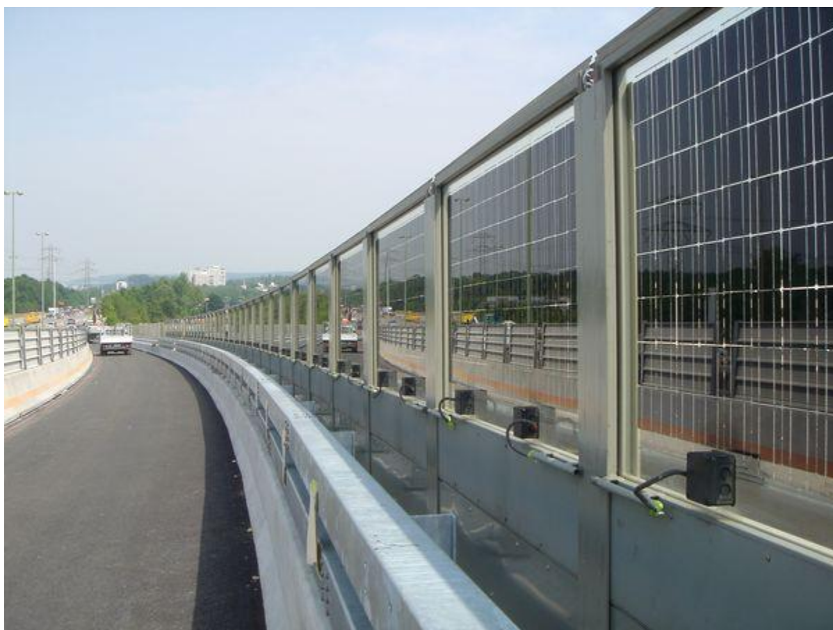
Рисунок 4.6 - Двосторонні сонячні батареї, встановлені на протишумових бар'єрах
