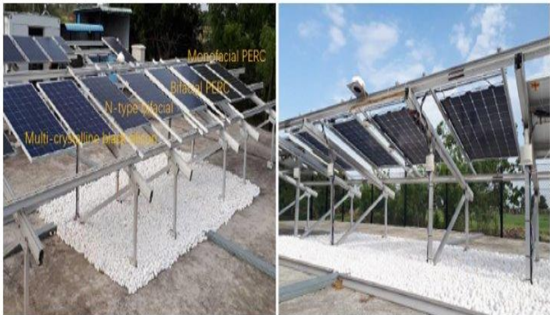
Рисунок 4.9 – Інсталяція сонячних панелей
