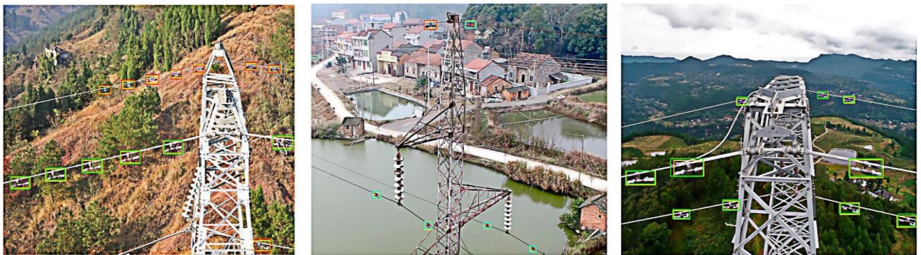
Рисунок 3.3 – Результати мережі PMA-YOLO з виявлення стану гасників коливань
