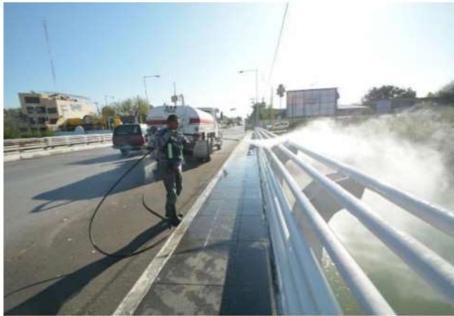
Рисунок 1.8 - Очищення парпетів
