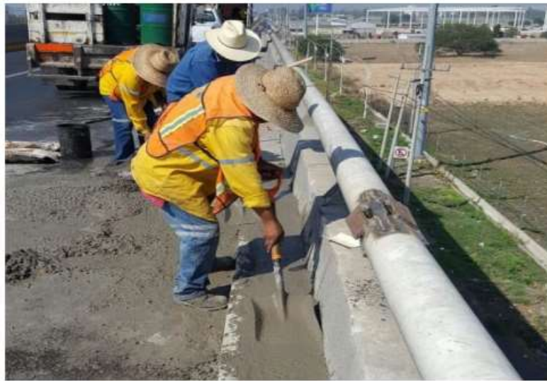
Рисунок 1.14 - Ремонт прокладок і тротуарів
