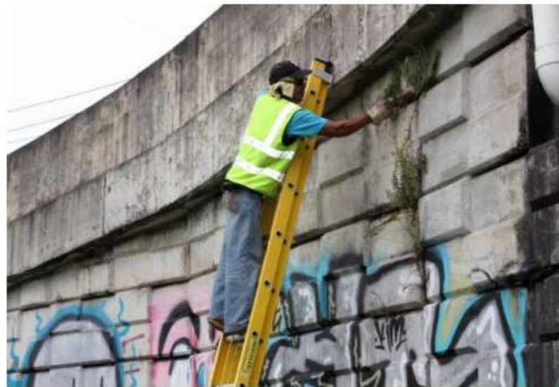
Рисунок 1.9 - Очищення швів армованих земляних стін
