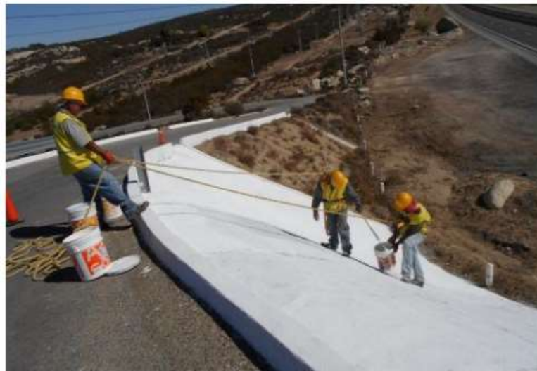
Рисунок 1.11 - Фарба на захисних плитах і конусах розливу
