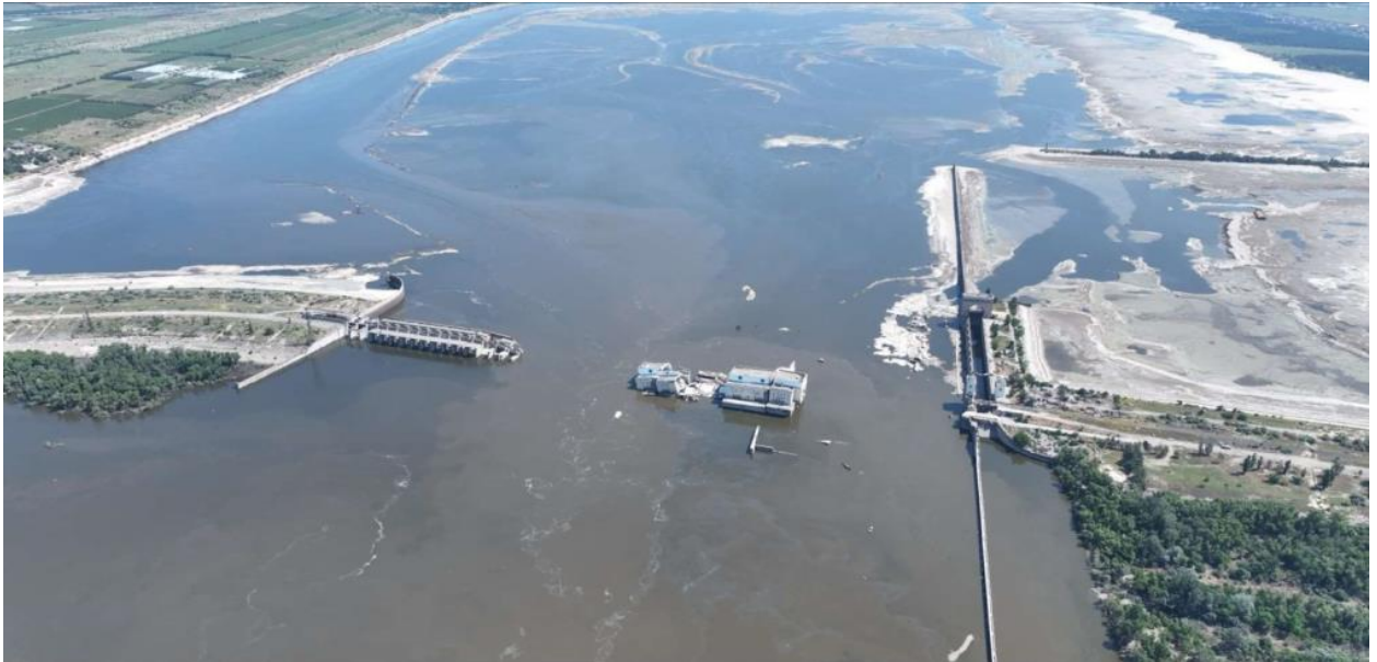
Рисунок 2.7 – Каховський гідровузол станом на 20.06.2023 р. після руйнування
