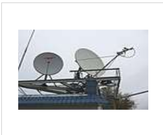
Рисунок 1.4 — Офсетні параболічні дзеркальні антени
