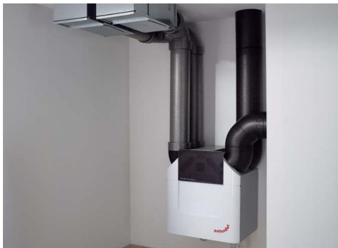
Рисунок 3.3 – Система вентиляції Zehnder ComfoAir Q450
