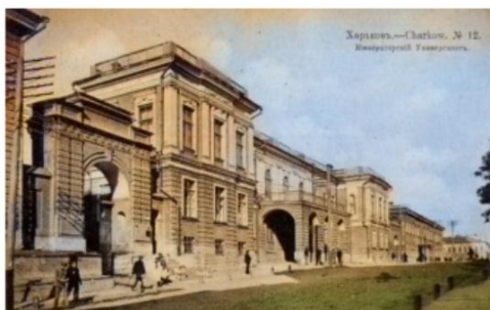
Рисунок 3.5 – Другий приклад (фасад університетської будівлі)
