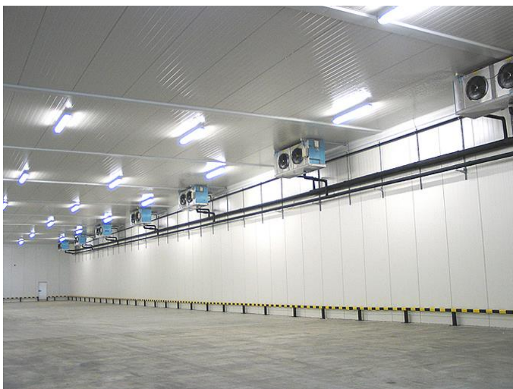
Рисунок 1.11 – Вентиляційна система в холодильному сховищі [14]
