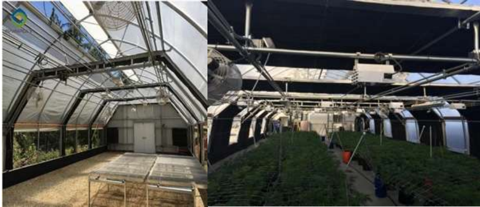
Рисунок 1.6 – Зовнішній вигляд теплиці фірми Sainpoly
