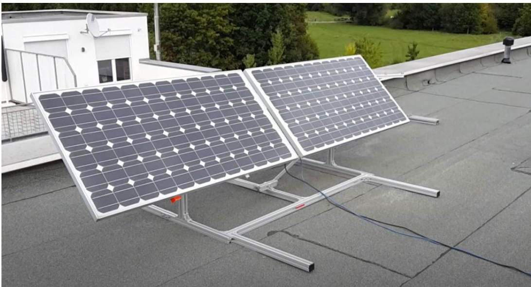
Рисунок 1.4 – Конструкція фіксованого положення сонячних панелей
