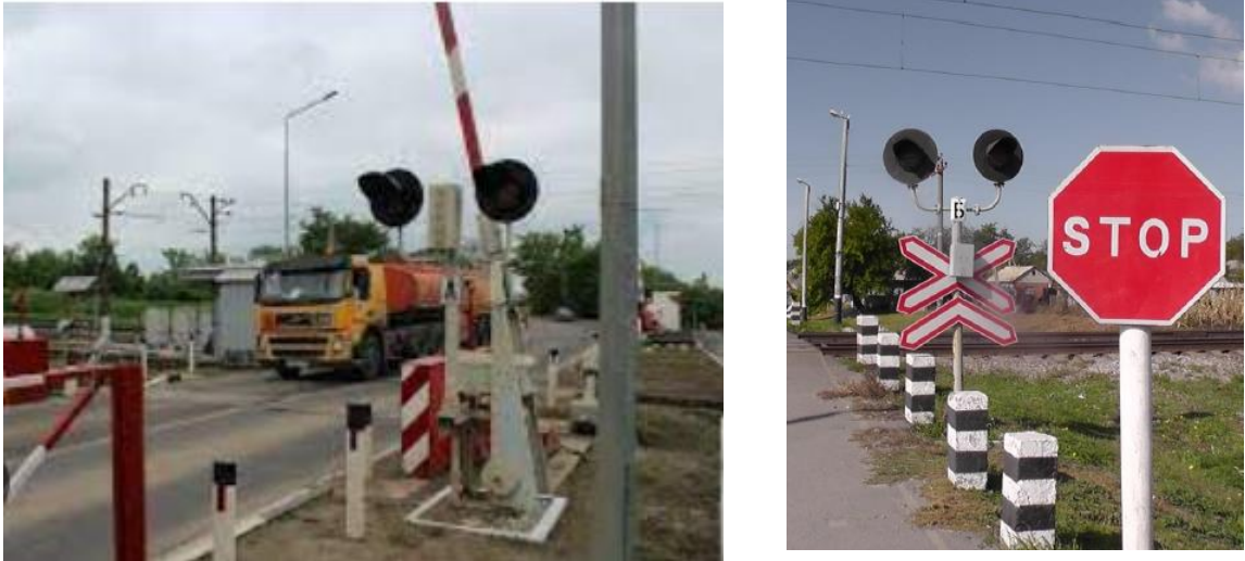
Рисунок 1.4 – Технічна реалізація системи безпеки автоматичного залізничного переїзду
