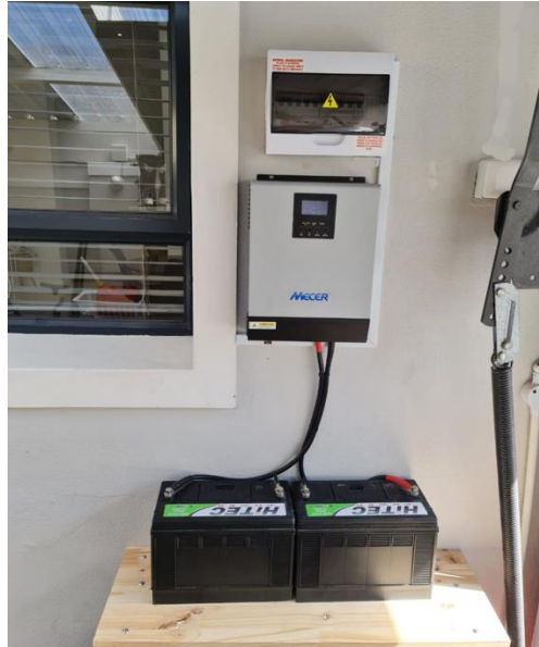
Рисунок 1.10 – Автоматична система аварійного електропостачання [8]
