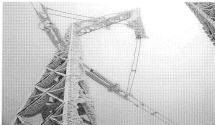
Рис. 1. Гололёдообразование на ВЛ 330кВ Черкесск- Баксан
