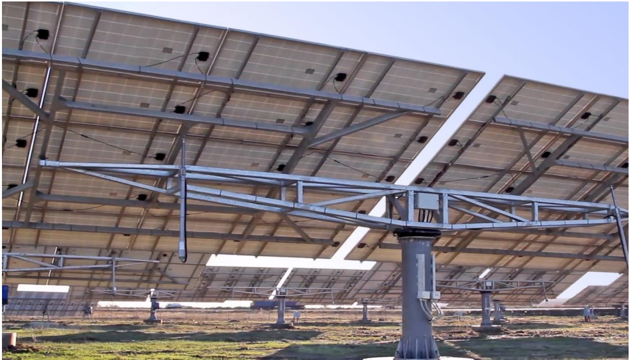
Рисунок 5.3 – Сонячна батарея з системою орієнтації
