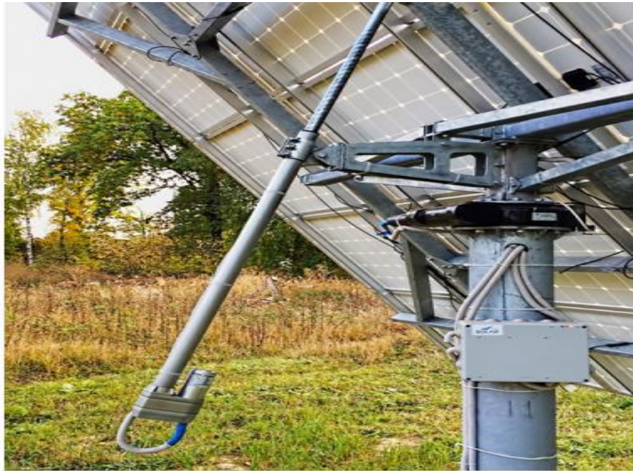
Рисунок 5.2 – Сонячний трекер з мотопідвісом
