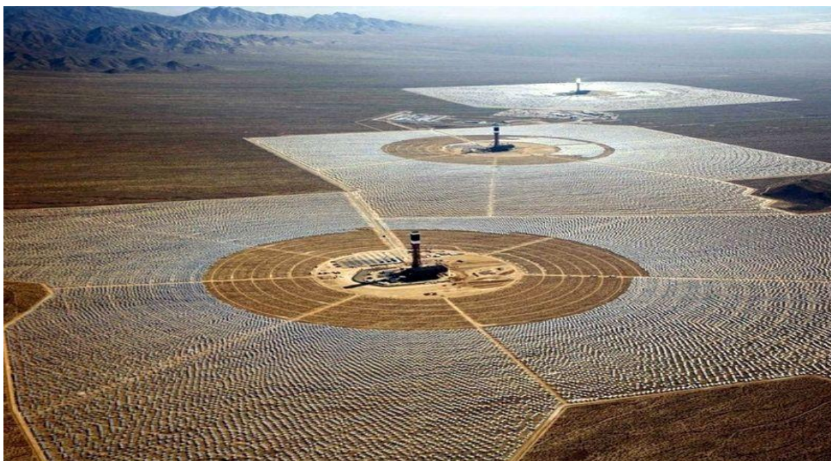
Рисунок 1.1 – Сонячна термальна електростанція в іспанському місті Севілья
