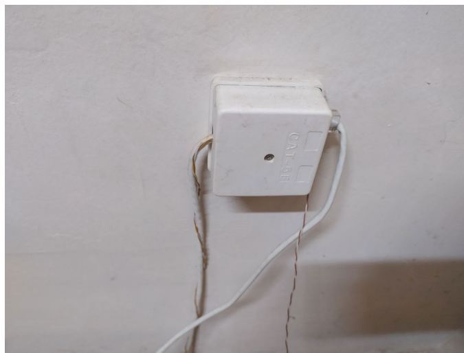
Рисунок 4.4 – Настінний бокс для кабелю
