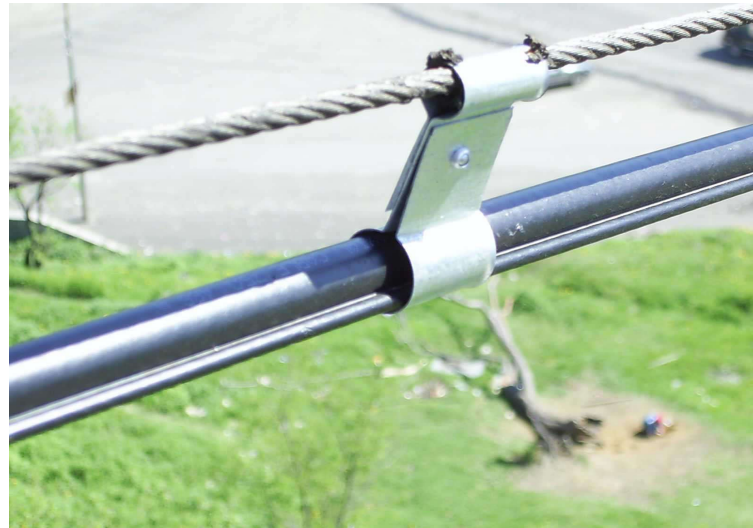
Рисунок 3.2 - Підвіс ОК до сталевого троса
