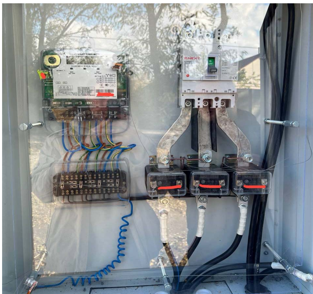
Рисунок 4.6 – Трифазна схема підключення лічильника
