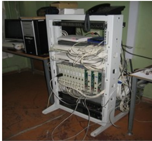
Рис. 12. Стійка з мережним устаткуванням і відомчої системи зв'язку «102» в ГУМВСУ в Харківській області
